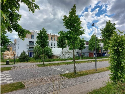
Figur 6. Nybyggeri og infrastruktur på Farum Kaserne.
